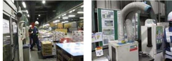
掲示板の前に置かれたスポットクーラー
